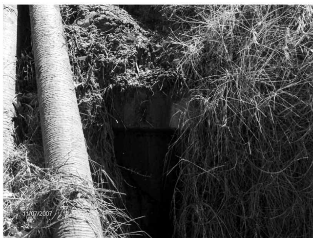
Figure 4. Erosion du remblai au dessus de la coupole.
