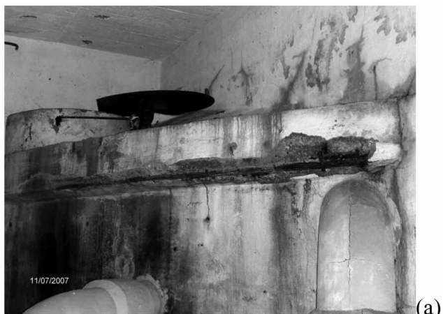
Figure 5 : Aciers de la ceinture supérieure corrodés.
