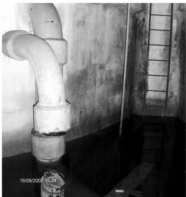
Figure 6. Chambre des vannes inondée.
