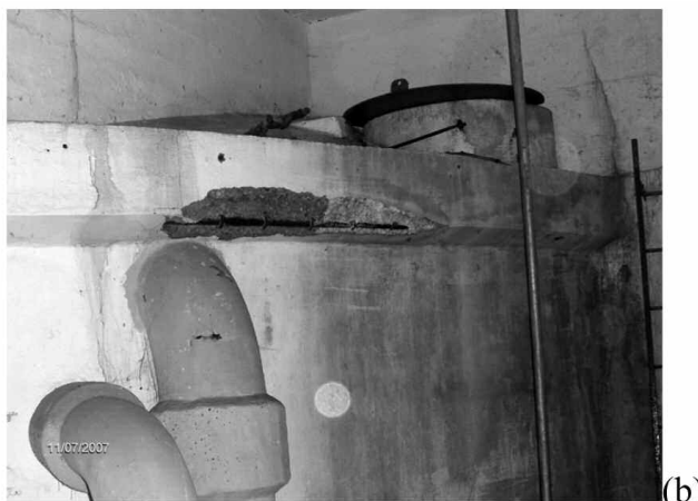
Figure 5 : Aciers de la ceinture supérieure corrodés.
