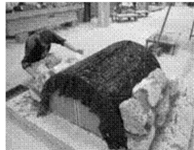
Figure 7. Positionnement des pierres
