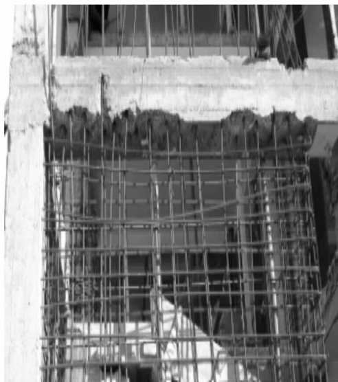
Figure 3 : Incorporation d'un voile en béton armé dans un portique [4]
