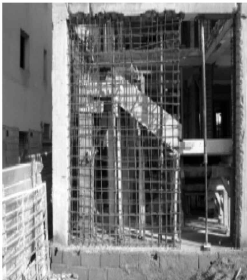
Figure 3 : Incorporation d'un voile en béton armé dans un portique [4]
