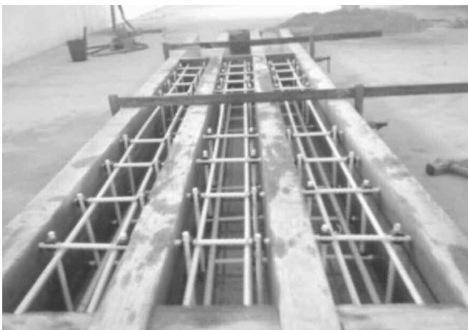
Figure 2 : Coffrage et coulage du béton
