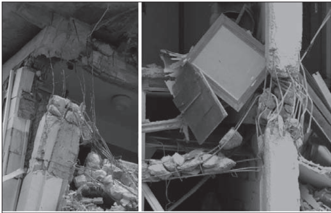
Figure 10. Conséquences de la mauvaise conception et réalisation des liaisons poteaux-poutres
