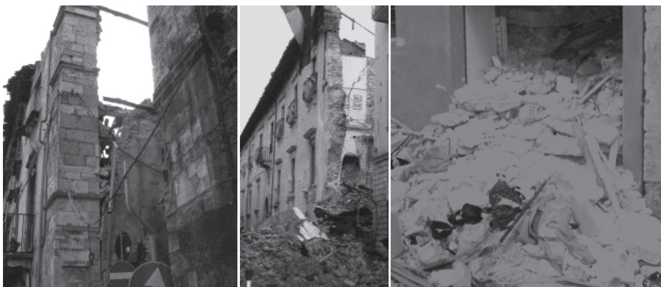
Figure 6. Ruine des planchers du bâtiment de l'Université d'Histoire des Abruzzes L'Aquila - Gravas issus des étages remplissant le RdC, Via Delle Carceri
