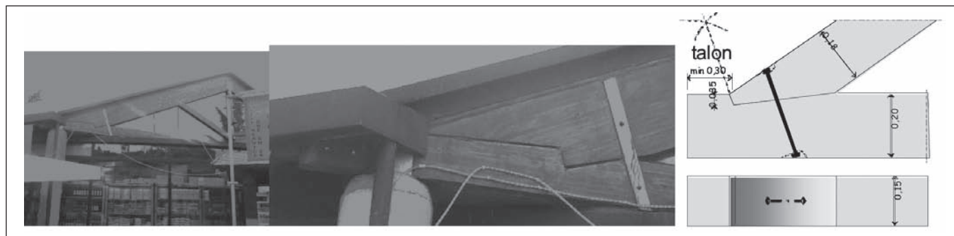
Figure 14. Assemblages bois travaillant par contact avec embrèvement décalé et dispositifs de maintien pour écarter les ruptures fragiles – L'Aquila.
