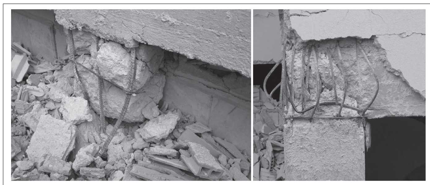
Figure 8. Retour à 90° des cadres de confinement
