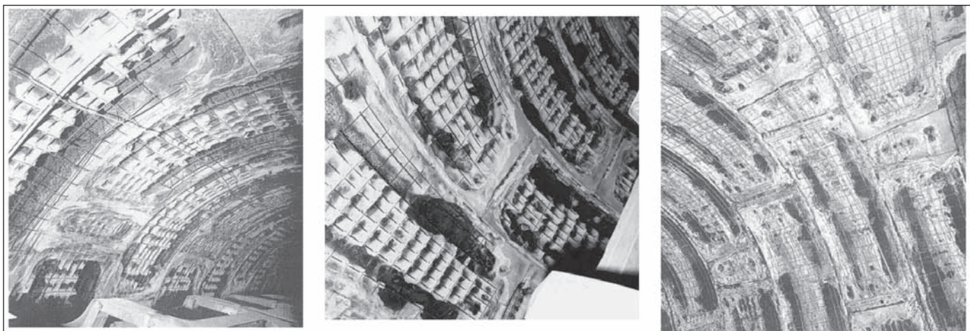
Figure 1 : photos des voussoirs du tunnel sous la Manche prises après l'incendie de 1996. Par endroits, l'épaisseur de béton des voussoirs a totalement été expulsée.
