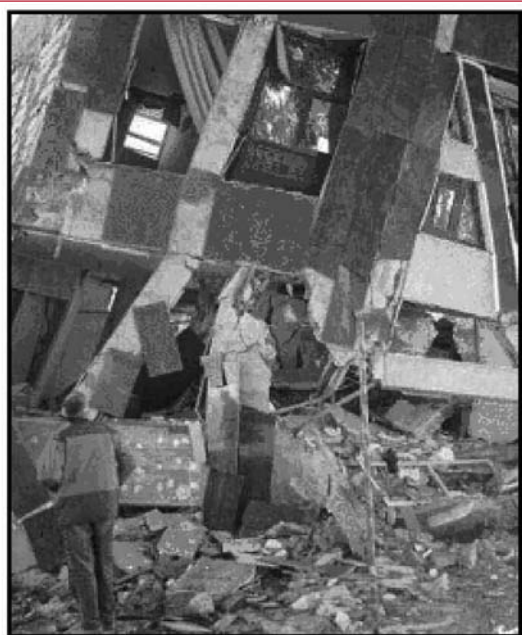
Figure 3. Effondrement d'un R+8 dû à l'éclatement des nœuds.
