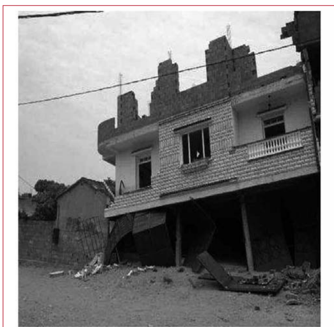
Figure 2. Effondrement d'un R+1 dû à la transparence du rez de chaussée.
