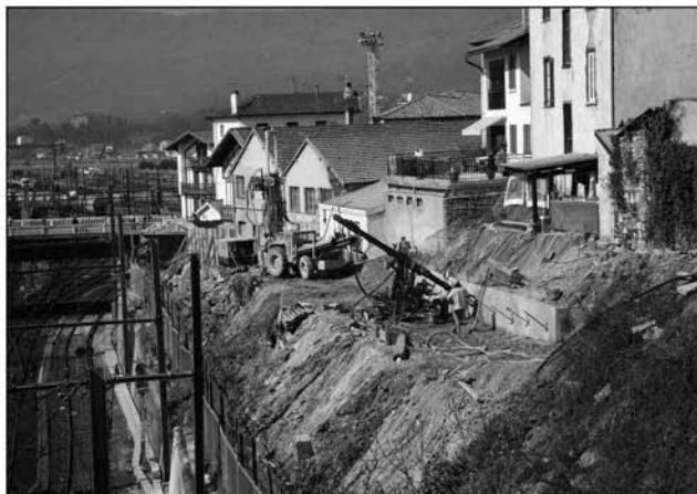
Figure 5. Ancrages provisoires en tête de talus et exécution du voile d'appui des poutres coté nord.
