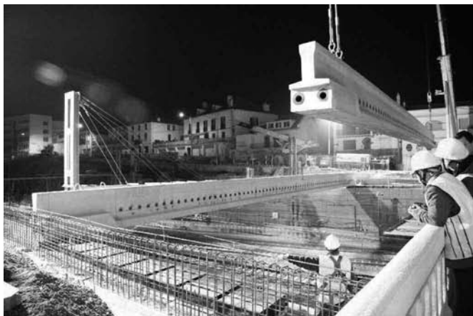
Figure 7. Dalle 1 en cours d'exécution : pose des premières poutres de 38 m de portée.
