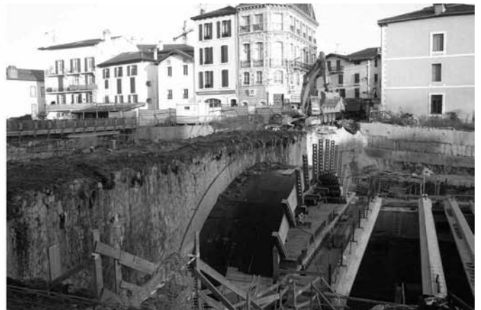
Figure 16. Mise en place du cintre pour la démolition du Pont-Vieux.
