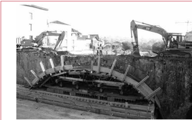
Figure 17. Pont-Vieux en cours de démolition et état d'avancement des travaux lors du démontage du voussoir de clé.
