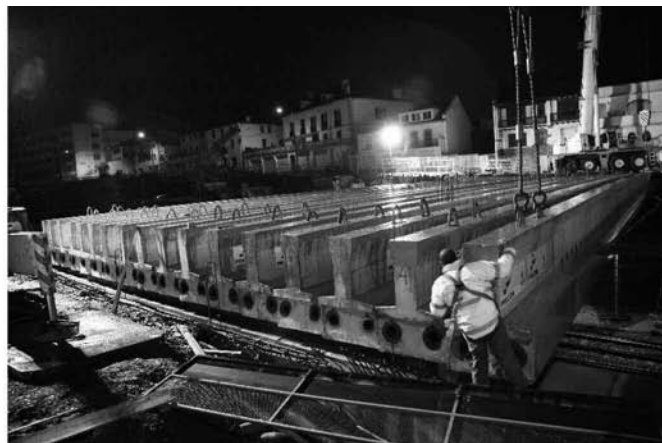
Figure 7. Dalle 1 en cours d'exécution : pose des premières poutres de 38 m de portée.
