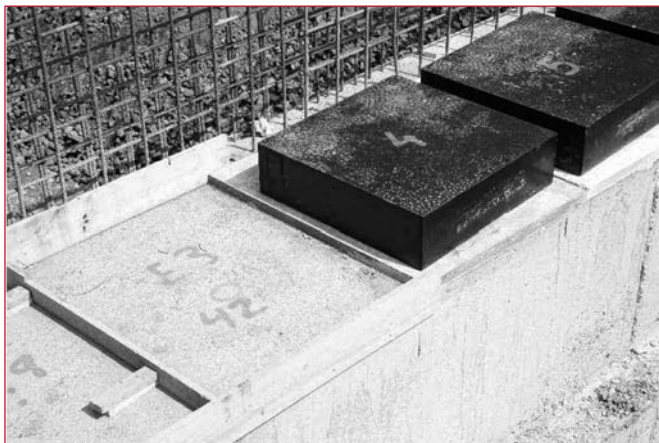
Figure 14. Appareils d'appui en néoprène fretté.
