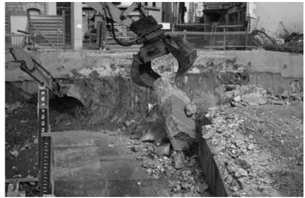
Figure 17. Pont-Vieux en cours de démolition et état d'avancement des travaux lors du démontage du voussoir de clé.
