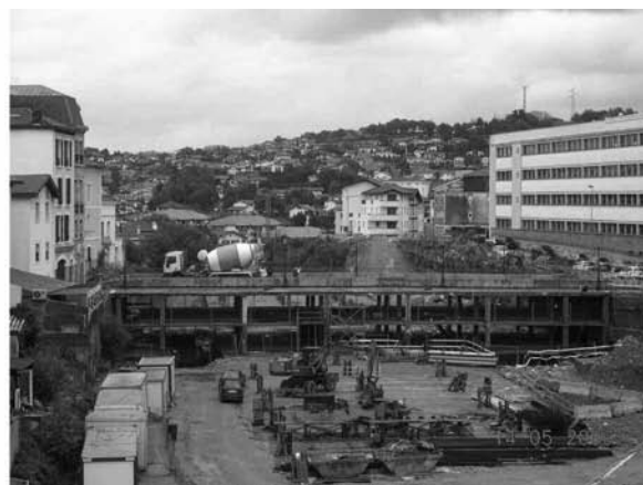
Figure 20. Dalle intermédiaire en cours d'exécution et épreuve de charge du « nouveau Pont-Vieux ».
