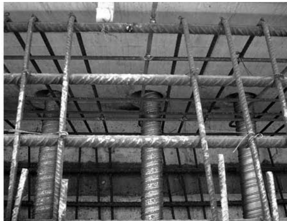
Figure 8. Ferrailage passif entre les poutres et gaines de la précontrainte transversale.
