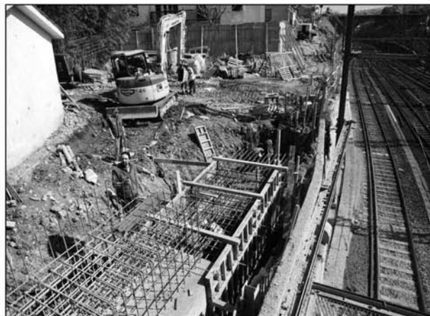
Figure 5. Ancrages provisoires en tête de talus et exécution du voile d'appui des poutres coté nord.
