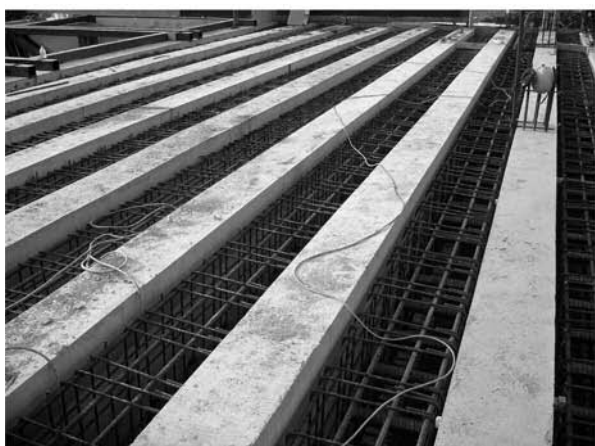
Figure 8. Ferrailage passif entre les poutres et gaines de la précontrainte transversale.
