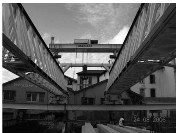
Figure 9. Portique lanceur des poutres en dalle courante.
