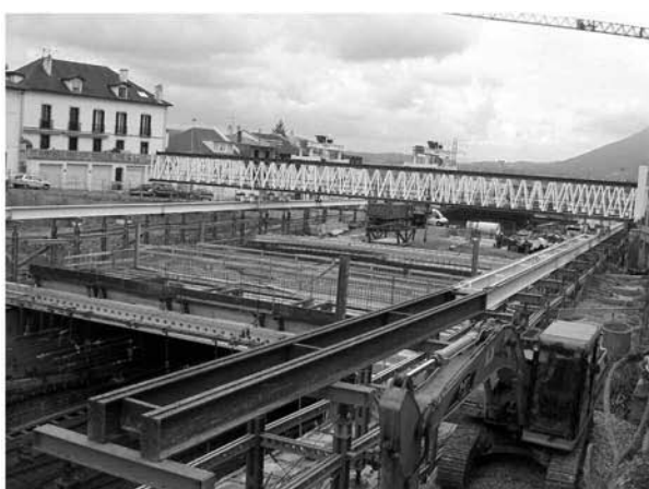
Figure 9. Portique lanceur des poutres en dalle courante.
