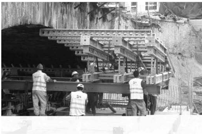
Figure 16. Mise en place du cintre pour la démolition du Pont-Vieux.
