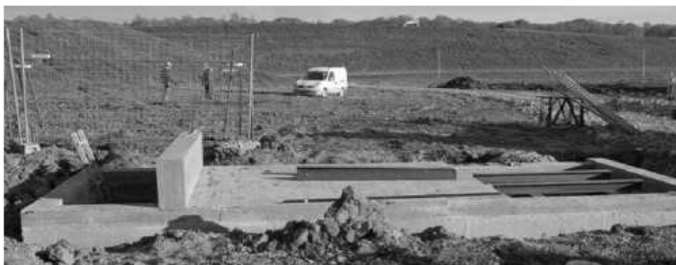
Figure 2. Fosse en béton armé (7 m x 4 m x 2 m).
