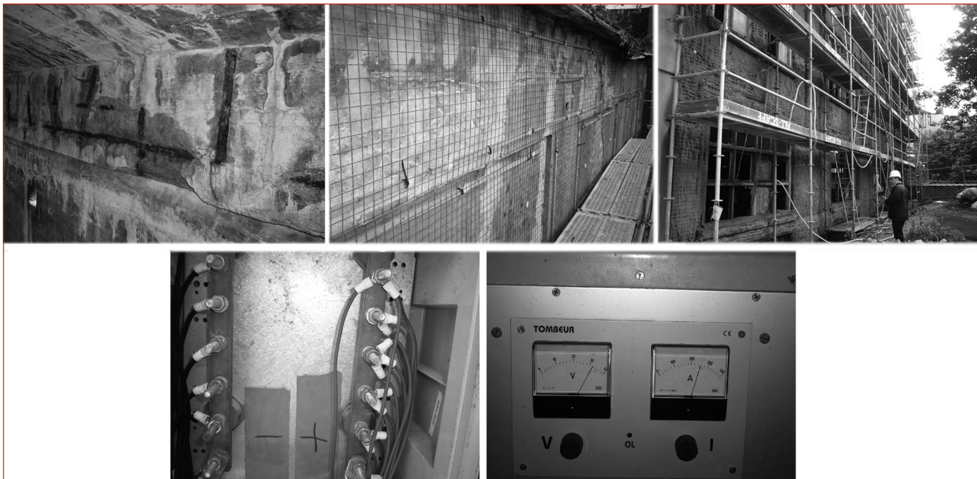
Photo 2 : Illustration du traitement de réalcalinisation par courant imposé (crédit photo Renofors).
