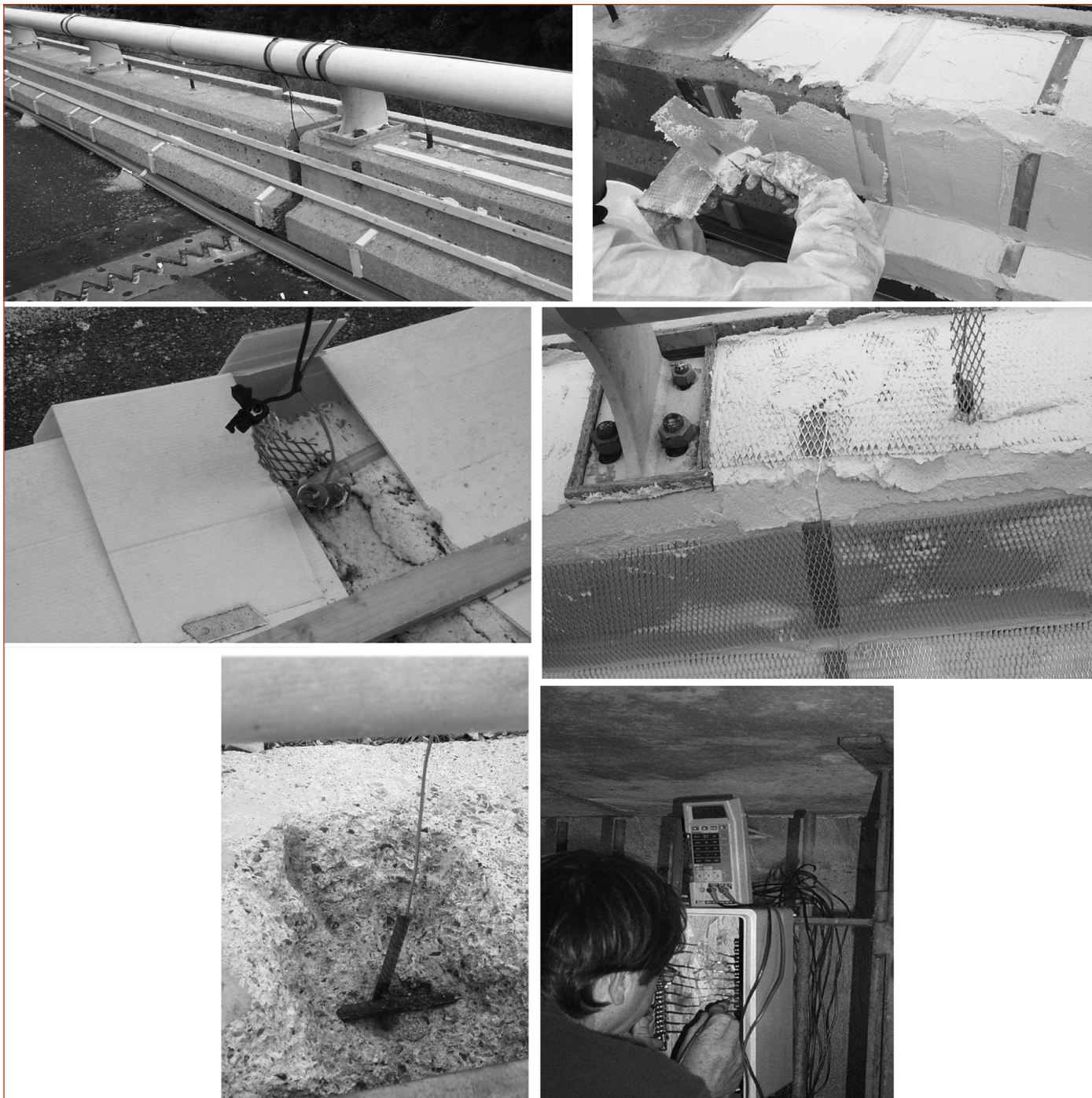
Photo 3 : Illustration du traitement de déchloration par courant galvanique (crédit photo Freyssinet).
