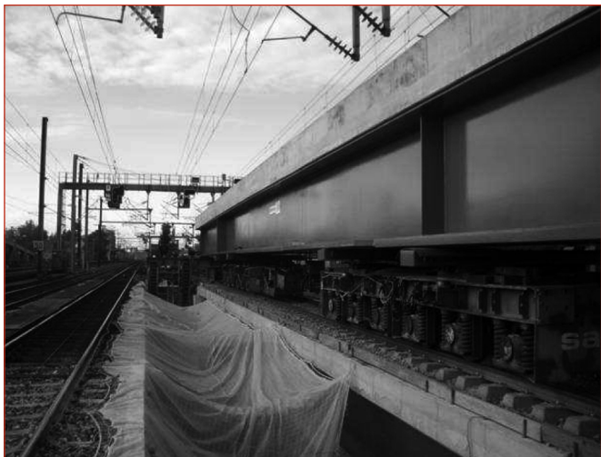
Figure 20: Amenée de la nouvelle travée.
