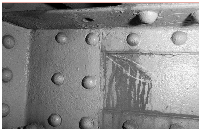
Figure 8: Exemple de fissure de fatigue.
