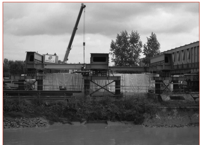
Figure 13: Charpente métallique du nouveau tablier.
