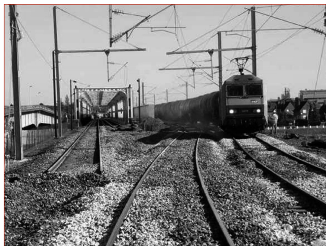
Figure 18: Circulation sur le tablier neuf en situation provisoire.
