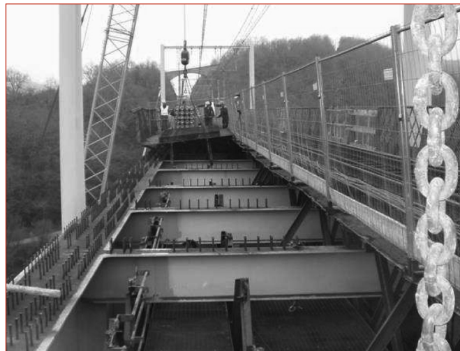
Figure 22: Dépose du demi-tablier de l'ouvrage ancien.
