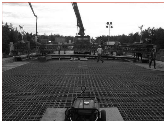
Figure 3: Tablier de pont en béton armé de PRFV.
